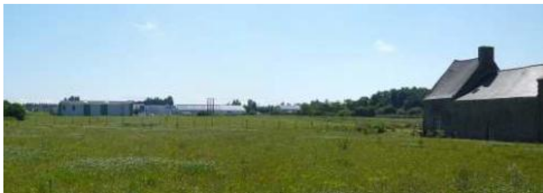
Figure 20 : vue photographique sur la partie Nord du terrain retenu pour le projet depuis l'Ouest
